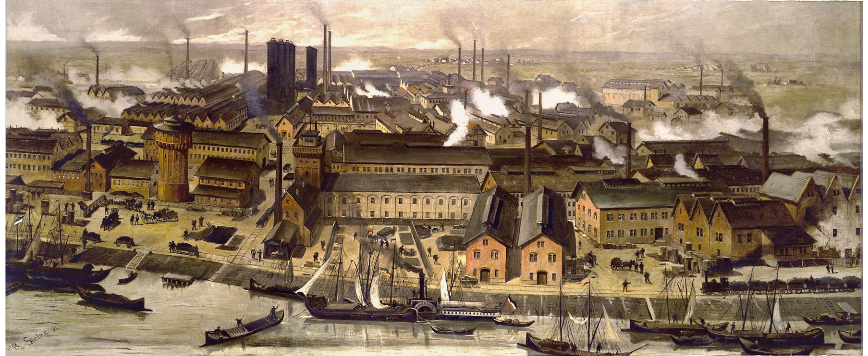
BASF Ludwigshafen site 1881 – von BASF Veröffentlicht unter CC BY-NC-ND 2.0 Lizenz https://www.flickr.com/photos/basf/5509563806/
